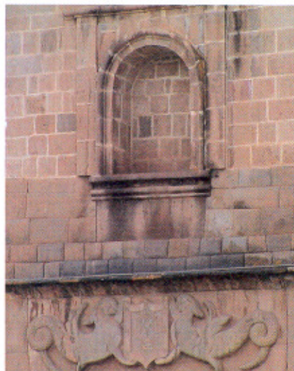
Unterschiedliche Mauern: Unterer Teil nach Inka-Art, oberer Teil im Stil der spanischen Konquistadoren: Welche wirkt optisch besser?
